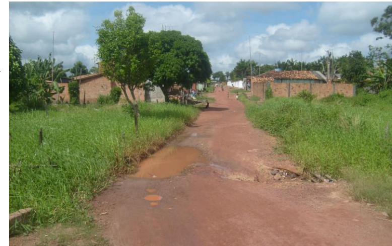
Figura 20 – Jardim das Acássias: rua sem pavimentação, drenagem e com espaços ociosos e sem limpeza (Foto: Flávia Cavalcante, 21/12/2010)
