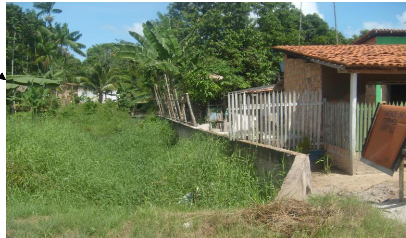
Figura 23 – Sta. Rita de Cássia: rua com esgoto a céu aberto, sem pavimentação, drenagem e limpeza (Foto: Flávia Cavalcante, 21/12/2010)
