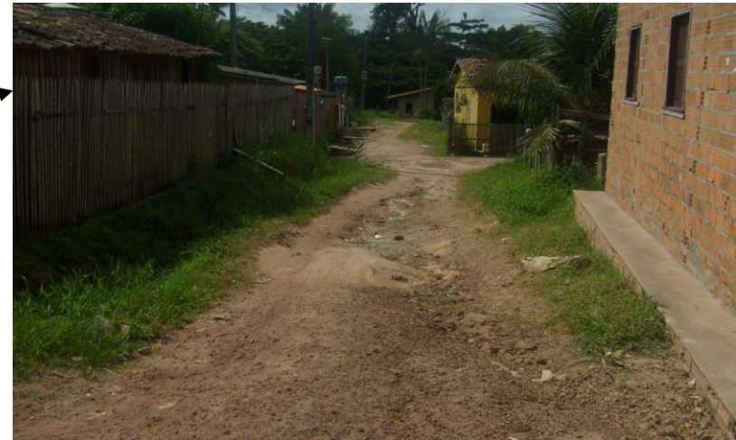
Figura 07 – Área Baixa do Tatu: rua sem drenagem e pavimentação (Foto: Flávia Cavalcante, 13/12/2010)
