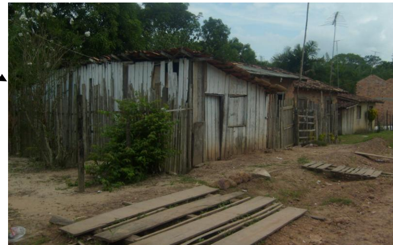
Figura 12 – Novo Horizonte: moradias precárias de madeira em rua sem pavimentação e rede de esgoto (Foto: Flávia Cavalcante, 15/12/2010)
