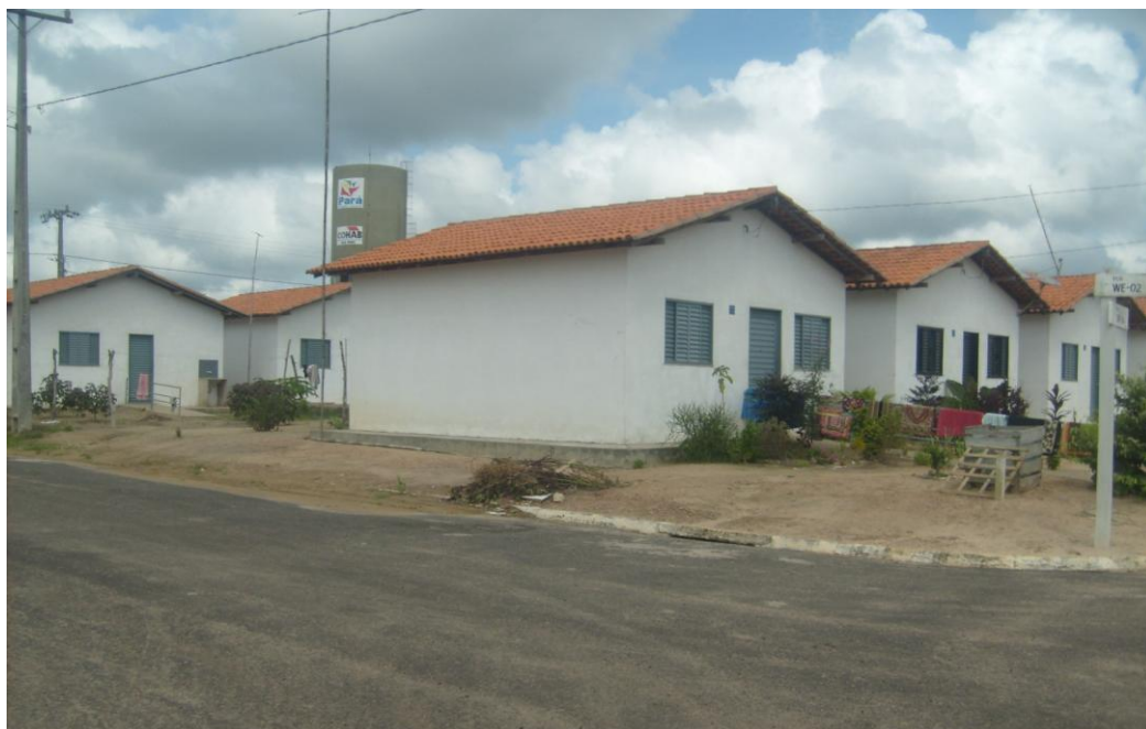
Figura 04 – Residencial Jardim das Garças: unidades habitacionais já ocupadas (Foto: Flávia Cavalcante, 21/12/10)
