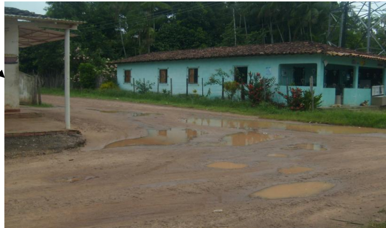
Figura 16 – Santa Terezinha: rua sem rede de esgoto e com pavimentação e drenagem precárias (Foto: Flávia Cavalcante, 16/12/2010)
