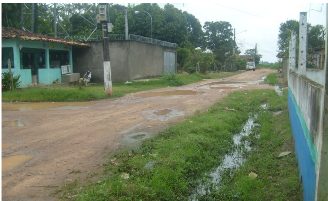
Figura 25 – Santa Terezinha: ocupação sem pavimentação e drenagem, dificultando a circulação de pedestres e automóveis (Foto: Flávia Cavalcante, 15/12/2010)
