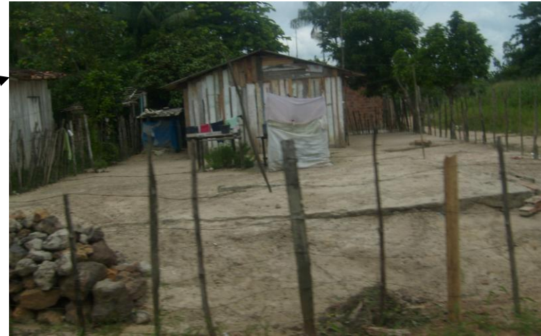
Figura 11 – Novo Horizonte: moradia precária construída em madeira (Foto: Flávia Cavalcante, 15/12/2010)
