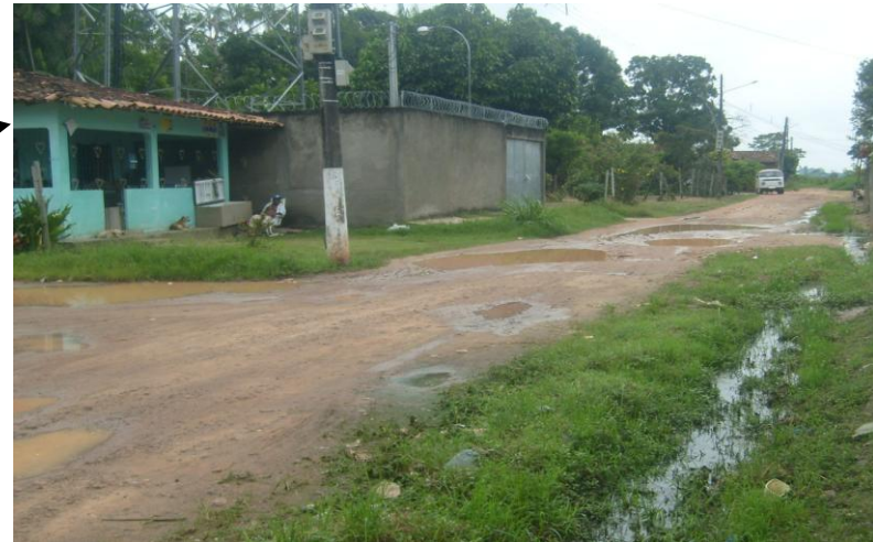
Figura 15 – Santa Terezinha: rua sem rede de esgoto e com pavimentação e drenagem precárias (Foto: Flávia Cavalcante, 16/12/2010)
