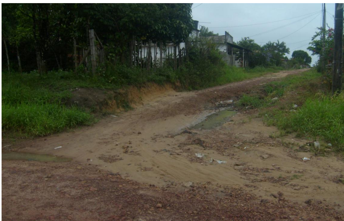
Figura 24 – Jardim Paraíso: ocupação sem rede de esgoto, pavimentação, limpeza e com precárias ligações de energia elétrica (Foto: Flávia Cavalcante, 15/12/2010)
